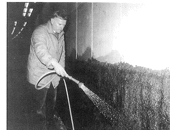
Fig. 11. Elektro-kemisk chloridudtrækning, kan vare op til 8 uger (det afhænger af betonens chloridindhold og tæthed). Den påsprøjtede cellulosemasse må ikke under processen udtørre og skal derfor vådholdes.
